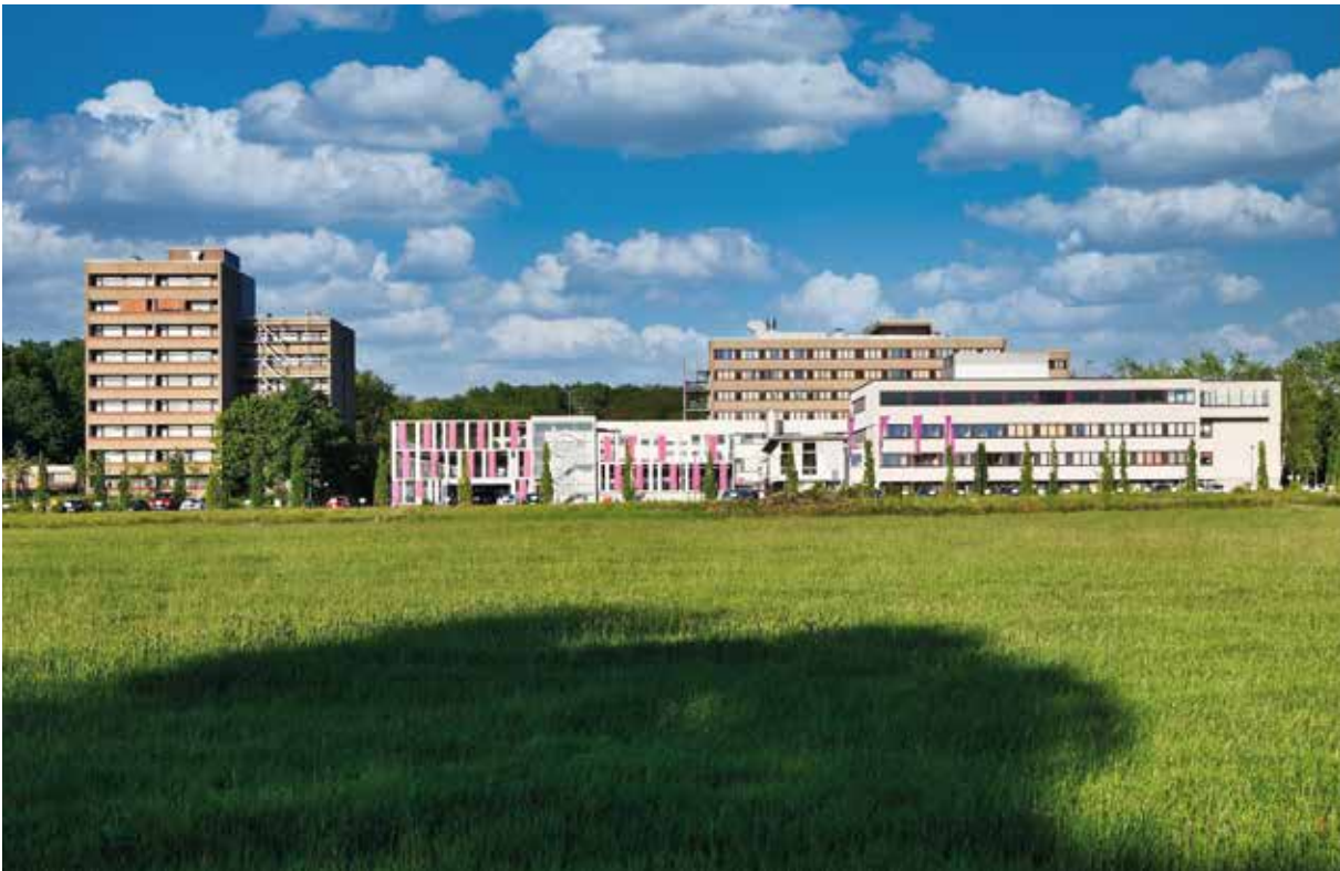
Der unverstellte Blick von der B 235 aus auf den Gebäudekomplex des EvK Castrop-Rauxel hat mittlerweile Nostalgiecharakter, denn auf der grünen Wiese an der Grutholzallee entsteht in unmittelbarer Nachbarschaft zum EvK der neue Gesundheitscampus.
